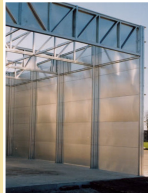
Fissaggio dei cassetti sulla struttura Fixing of the drawers on the structure Крепление панелей
