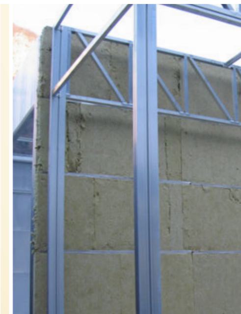
Montaggio Lana Minerale su Cassetti Mounting the Mineral Wool on Drawers Минеральная вата
